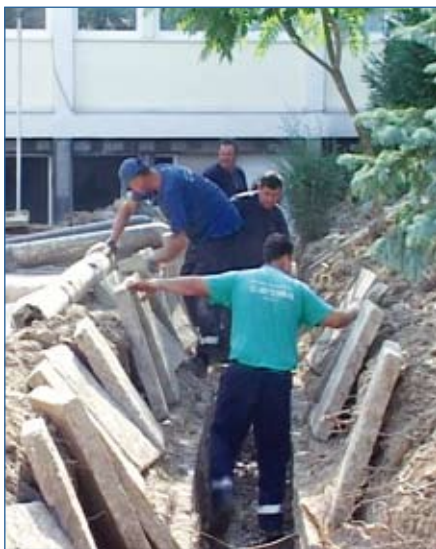
Реконструкција штиловодне мреже
